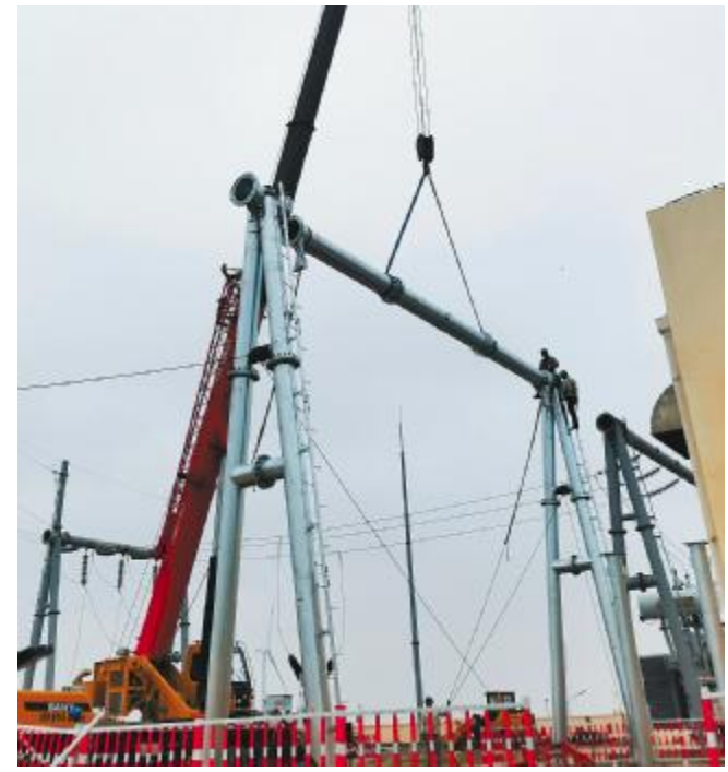
项目建设现场
